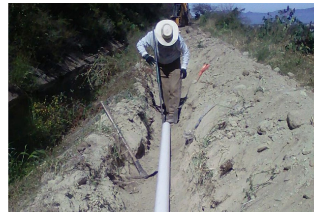
Construcción de línea de conducción del pozo La Cañada a la Cabecera Municipal, en el municipio de Tizapán el Alto, Jalisco.
