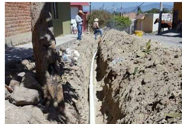
Rehabilitación de instalaciones hidráulicas en la colonia Dávalos Flores, en el municipio de Tizapán el Alto, Jalisco.
