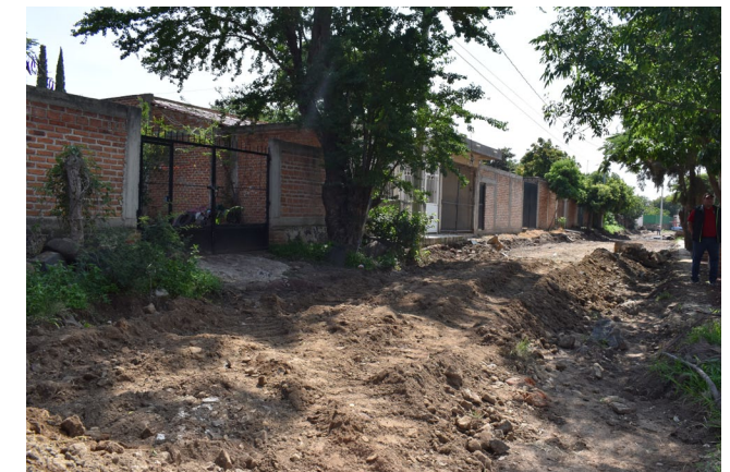
Construcción de empedrado tradicional y sustitución de red de agua potable y drenaje en la calle Canal, en el municipio de Tizapán el Alto, Jalisco.
