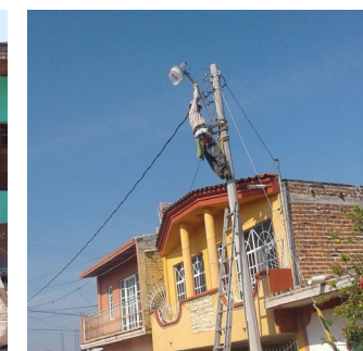
Electrificaciones en Cabecera Municipal.
