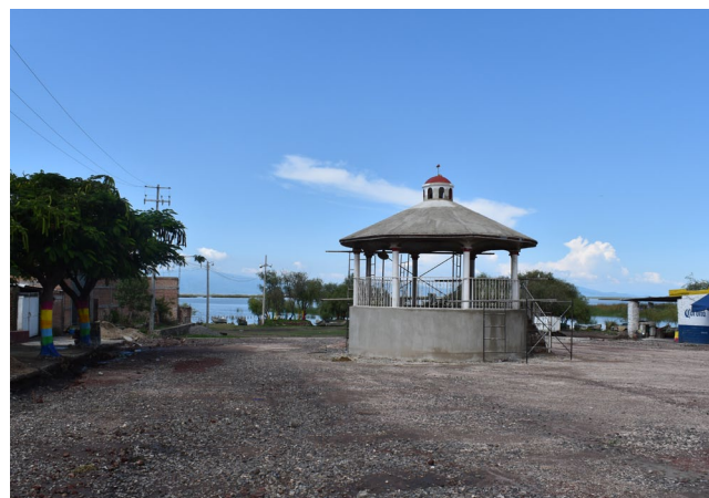
Rehabilitación de la plaza principal de la localidad de Misaloya, municipio de Tizapán el Alto, Jal.
