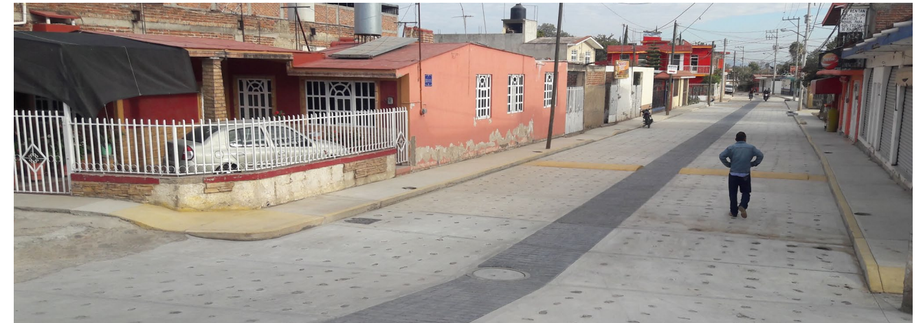
Construcción de pavimento de concreto hidráulico de la calle Emiliano Zapata en la Cabecera Municipal de Tizapán el Alto, Jalisco.
