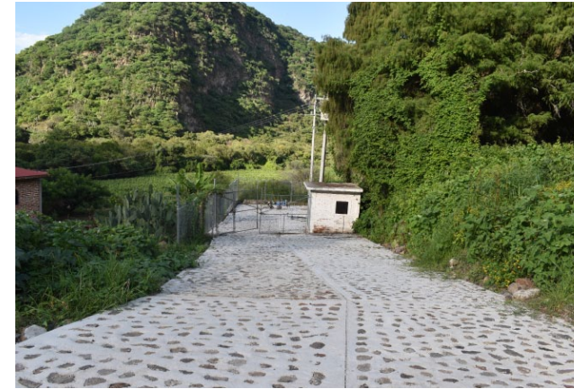
Equipamiento de pozo profundo de La Cañada, en el municipio de Tizapán el Alto, Jalisco.
