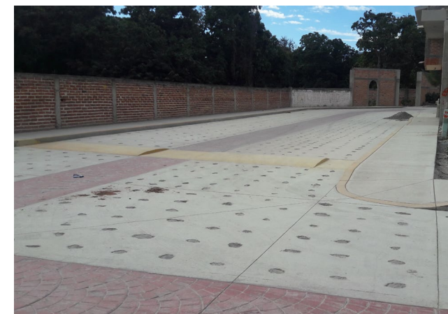
Construcción de pavimento de concreto hidráulico en la calle Privada Ramón Corona en la Cabecera Municipal de Tizapán el Alto, Jalisco.
