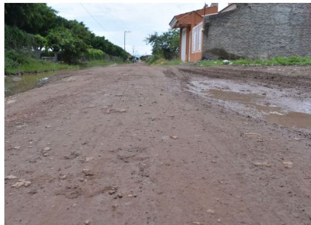
Construcción de empedrado tradicional con huella y banquetas en la calle Plan de Iguala.
