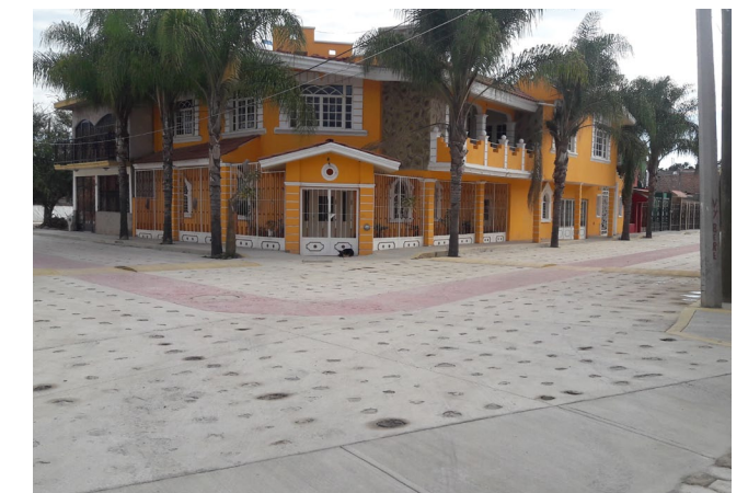
Construcción de pavimento de concreto hidráulico en la calle Paseo Ramón Corona en la Cabecera Municipal de Tizapán el Alto, Jalisco.
