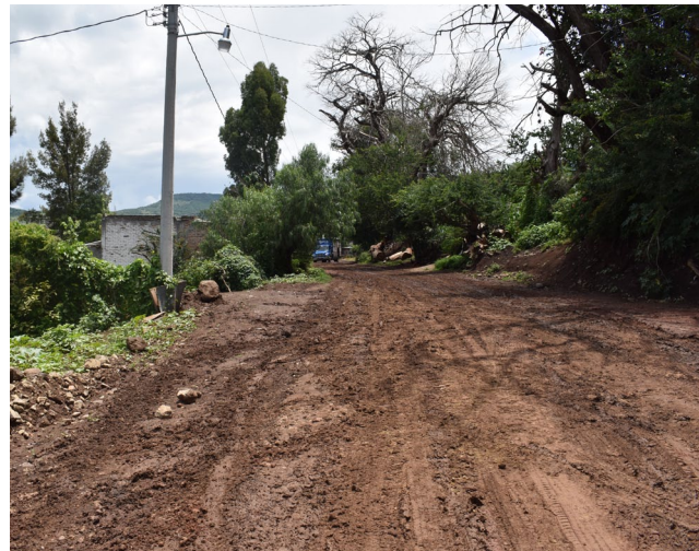
Construcción de camino a La Cañada segunda etapa.
