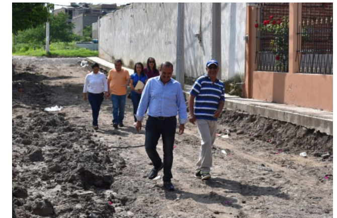
Construcción de concreto hidráulico y sustitución de red de agua potable y drenaje en la calle Colón, en el municipio de Tizapán el Alto, Jalisco.
